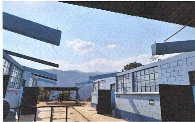
Foto 1: Desmontaje del techo en ambos modulos.
